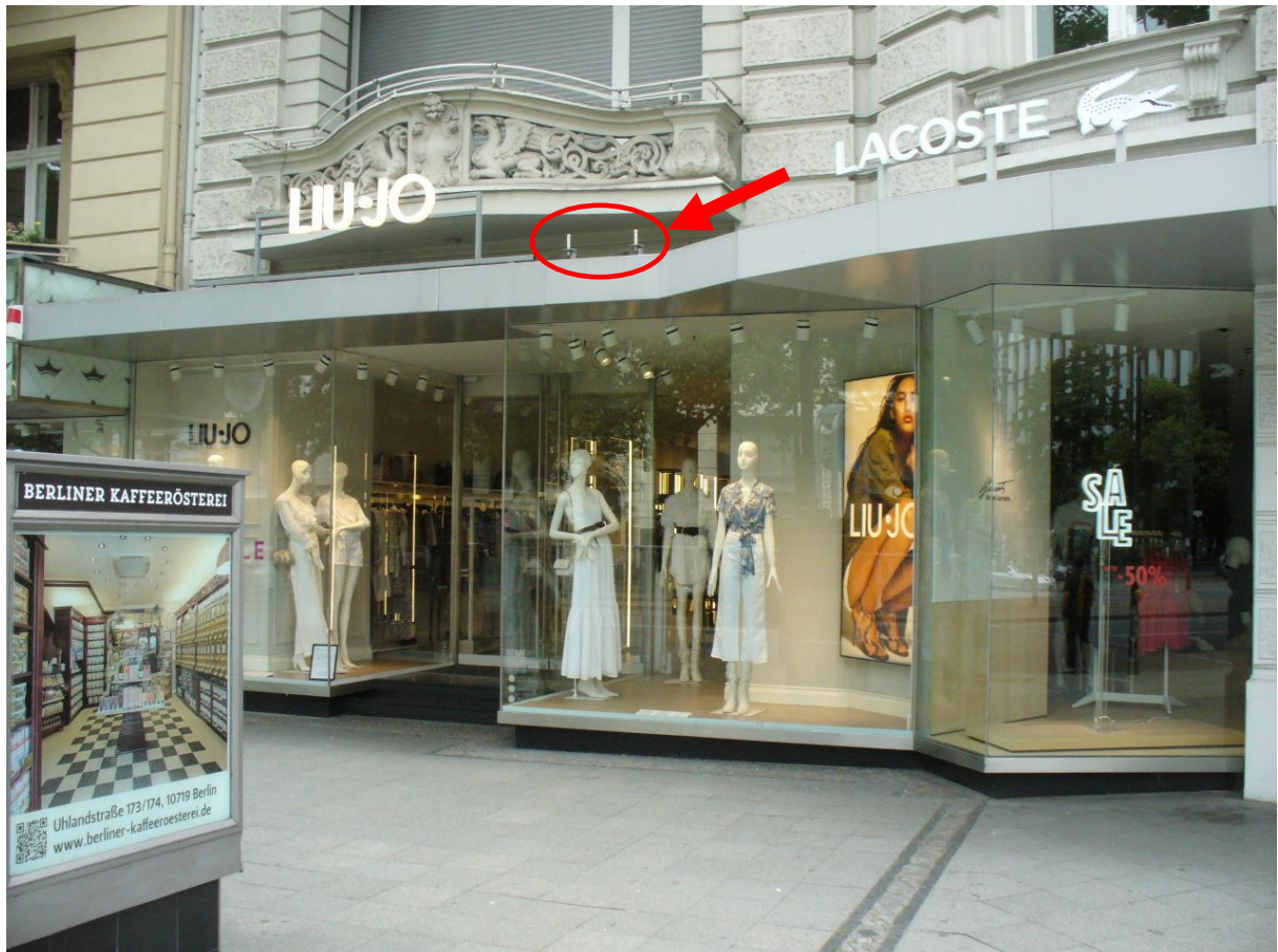
Bild 10.12.1: Standort 12: Antennen der Kleinzellenanlage (Telekom).
