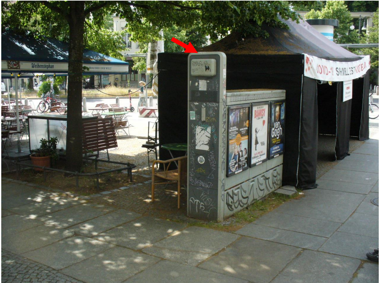
Bild 10.9.1: Standort 9: Antennen der Kleinzellenanlage (Telekom).
