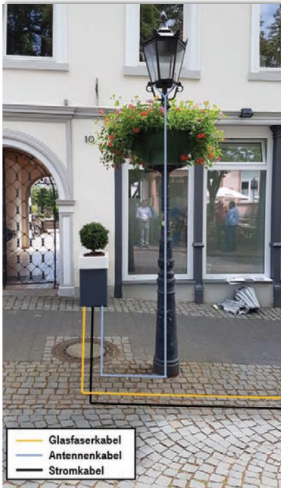
Small Cell Straßenlaterne < 10 W EIRP Sendeleistung
