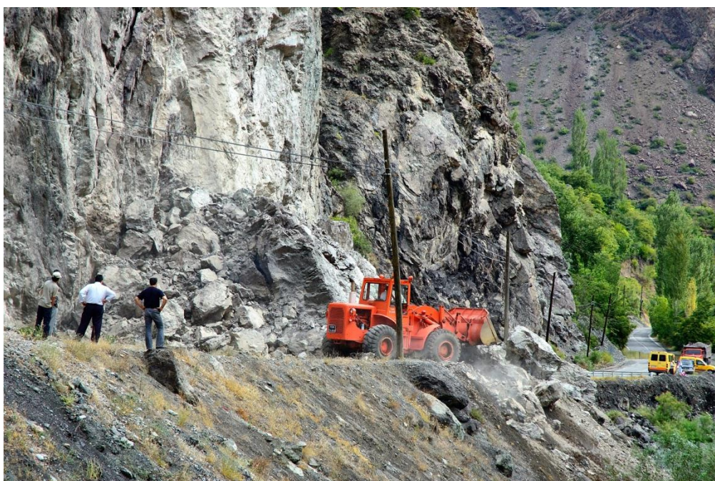
Повреждение инфраструктуры камнепадом после сильного дождя
