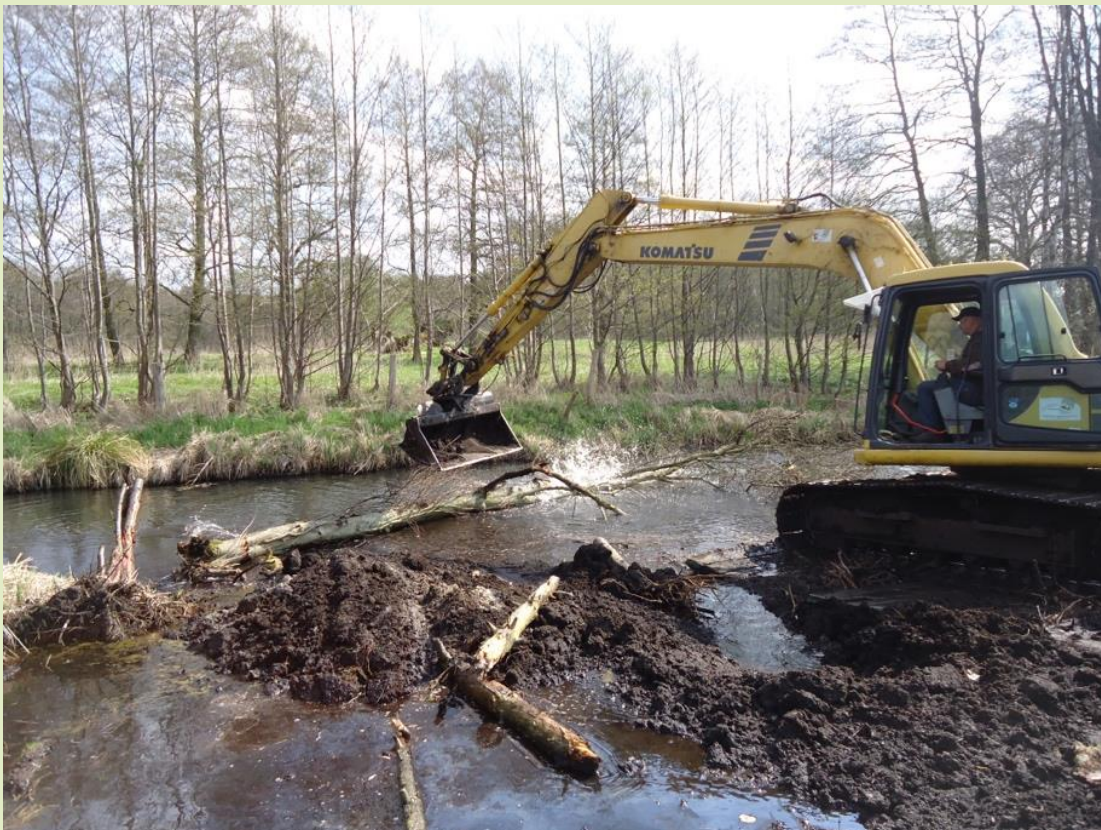
Abbildung 1 zeigt den Fluss Nebel in Deutschland während Renaturierungsarbeiten im Jahr 2013. Natürliche Elemente, wie Totholz, wurden in den Fluss eingebracht. Ziel ist die Förderung der naturnahen Flussdynamik und die Verbesserung der Lebensraumvielfalt. © Klaudia Lüdecke
