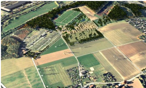
Umspannanlage Hagen-Garenfeld © Amprion GmbH
