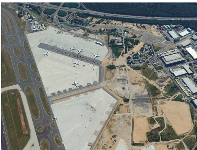
Terminal 3, Baufäche © Fraport AG
