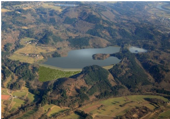
Haselbecken/Unterbecken © Schluchseewerk AG
