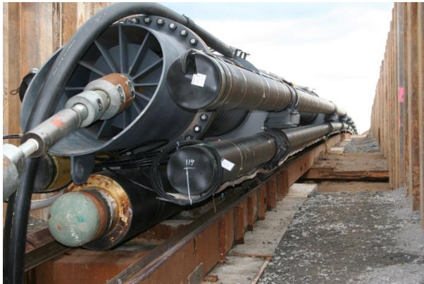
Rohrbündeleinzug © Shell Deutschland Oil GmbH
