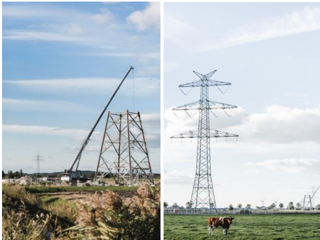
Westküstenleitung Mastbau 380 kV © TenneT TSO
