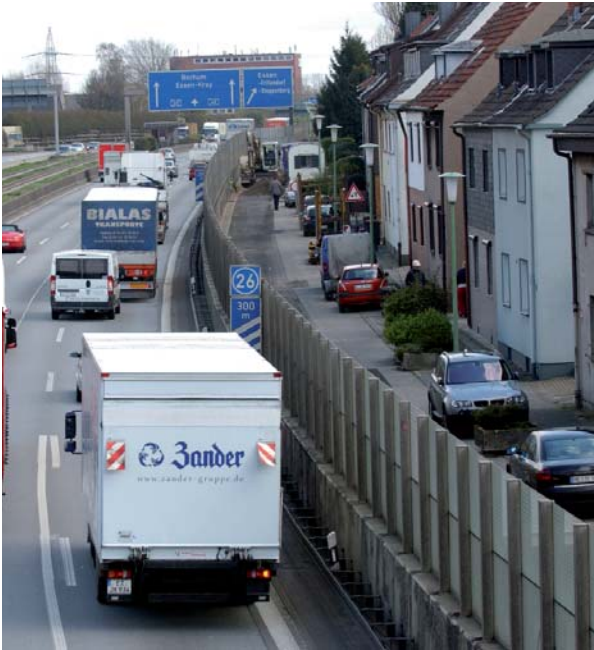
Lärmschutzwände helfen den Verkehrslärm für Anwohner zu reduzieren. (Foto: dpa)
