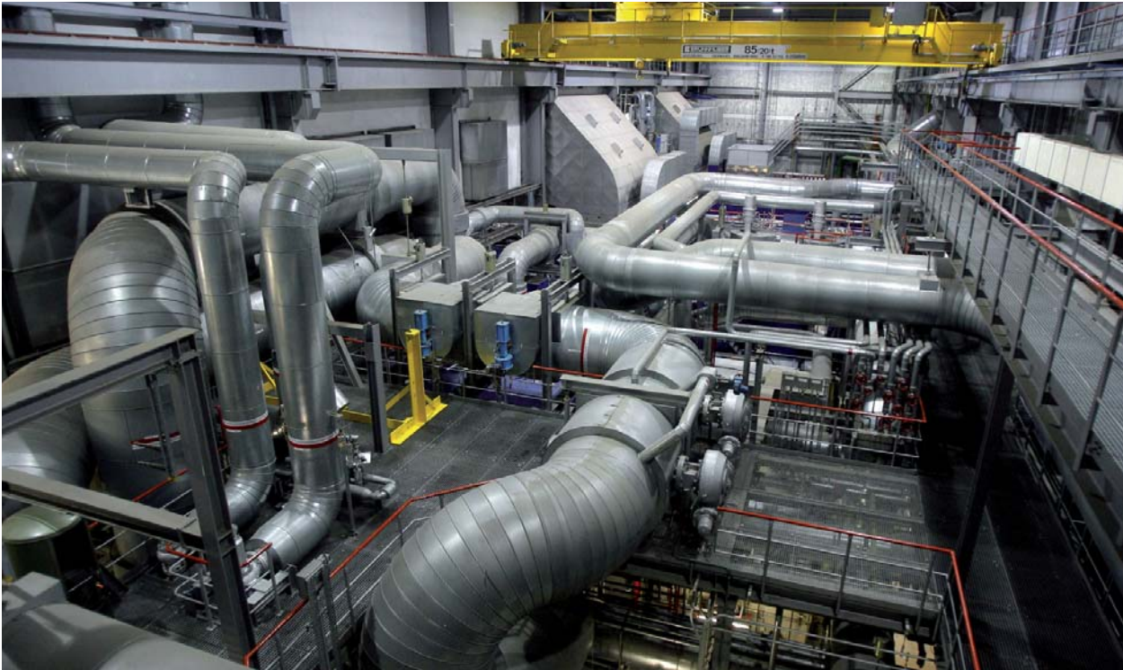
Blick in das Kesselhaus des Kraftwerks Berlin Mitte, in dem Strom und Wärme durch Kraft-Wärme-Kopplung zur Verfügung gestellt werden. (Foto: dpa)
