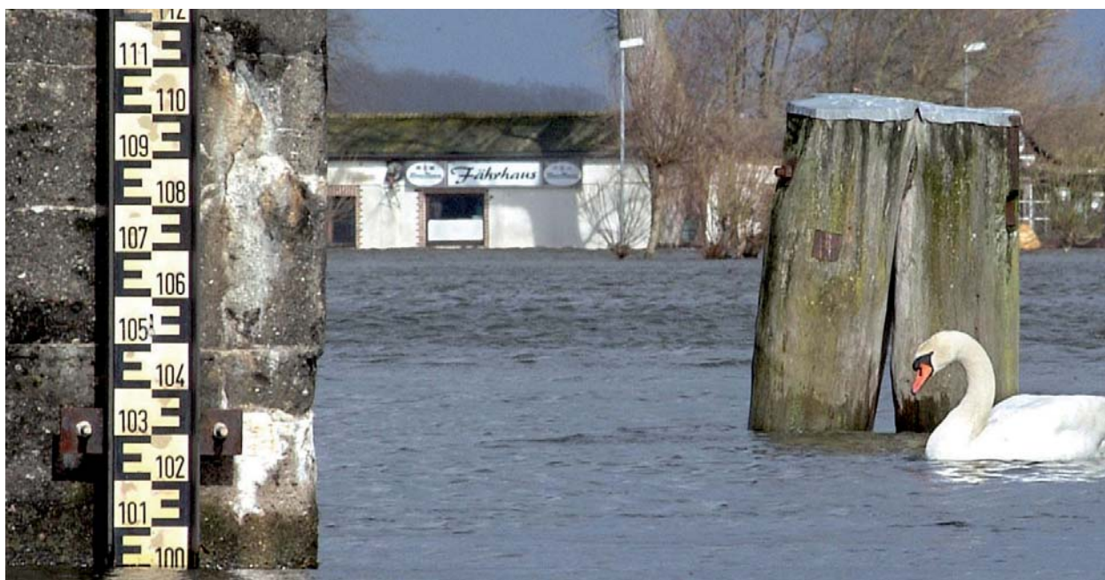
Hier ist die Elbe bei Bleckede (Kr. Lüneburg) über die Ufer getreten. (Foto: dpa)
